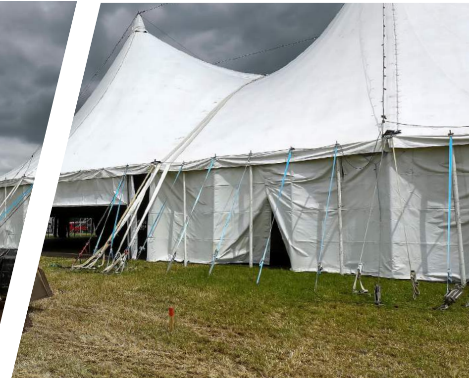
Der kompakte CAT 908M unterstützte unter anderem bei der Einrichtung der Infrastruktur
