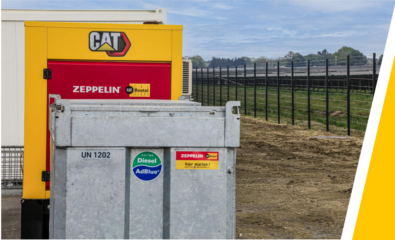
Der 3.000-Liter-Kombitank versorgt den Generator mit Kraftstoff sowie AdBlue
