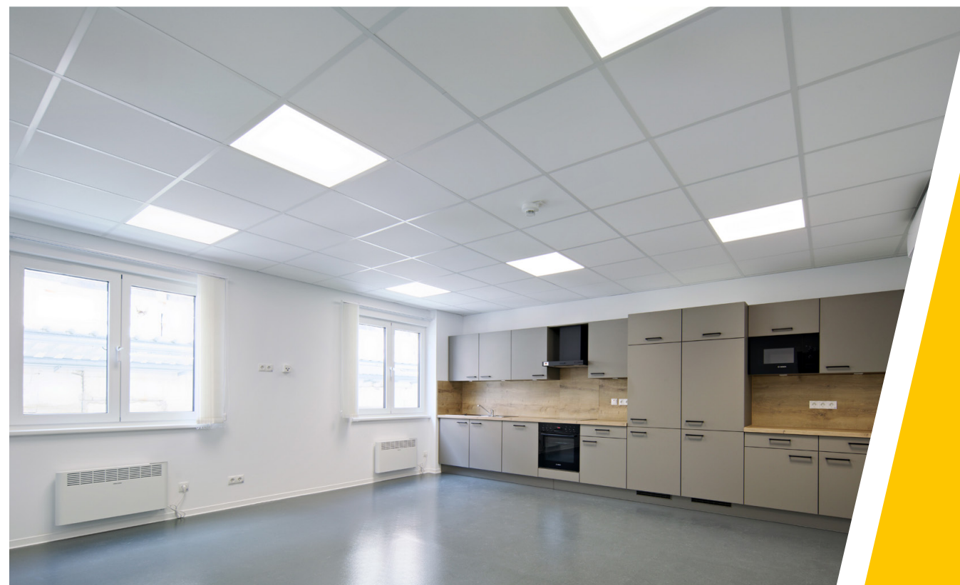
Die Anlage wurde mit Akustikdecken ausgestattet
