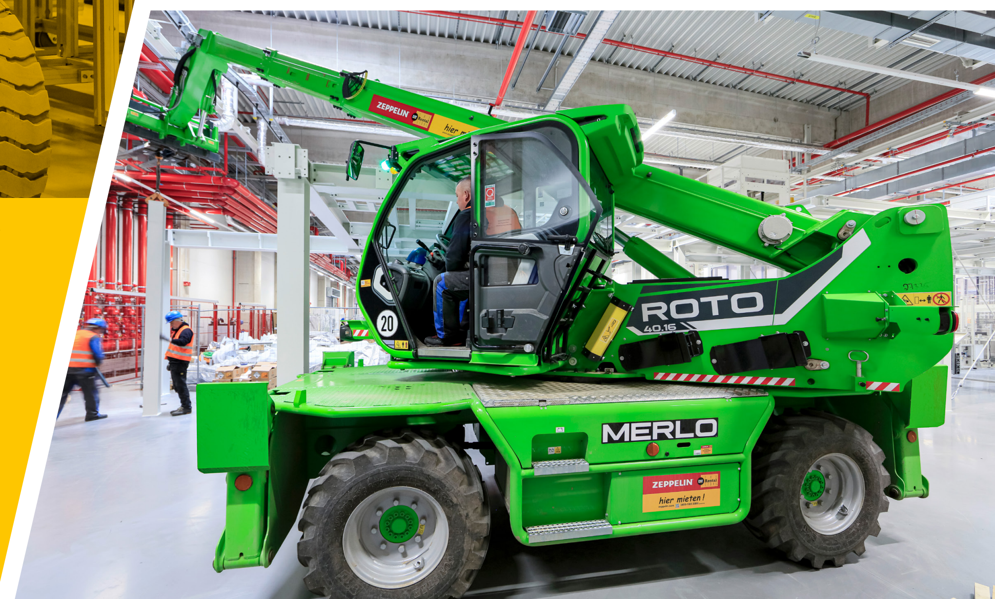
Teleskopstapler, Hochhubwagen und Polaris Ranger unterstützten die Materiallogistik auf dem Gelände
