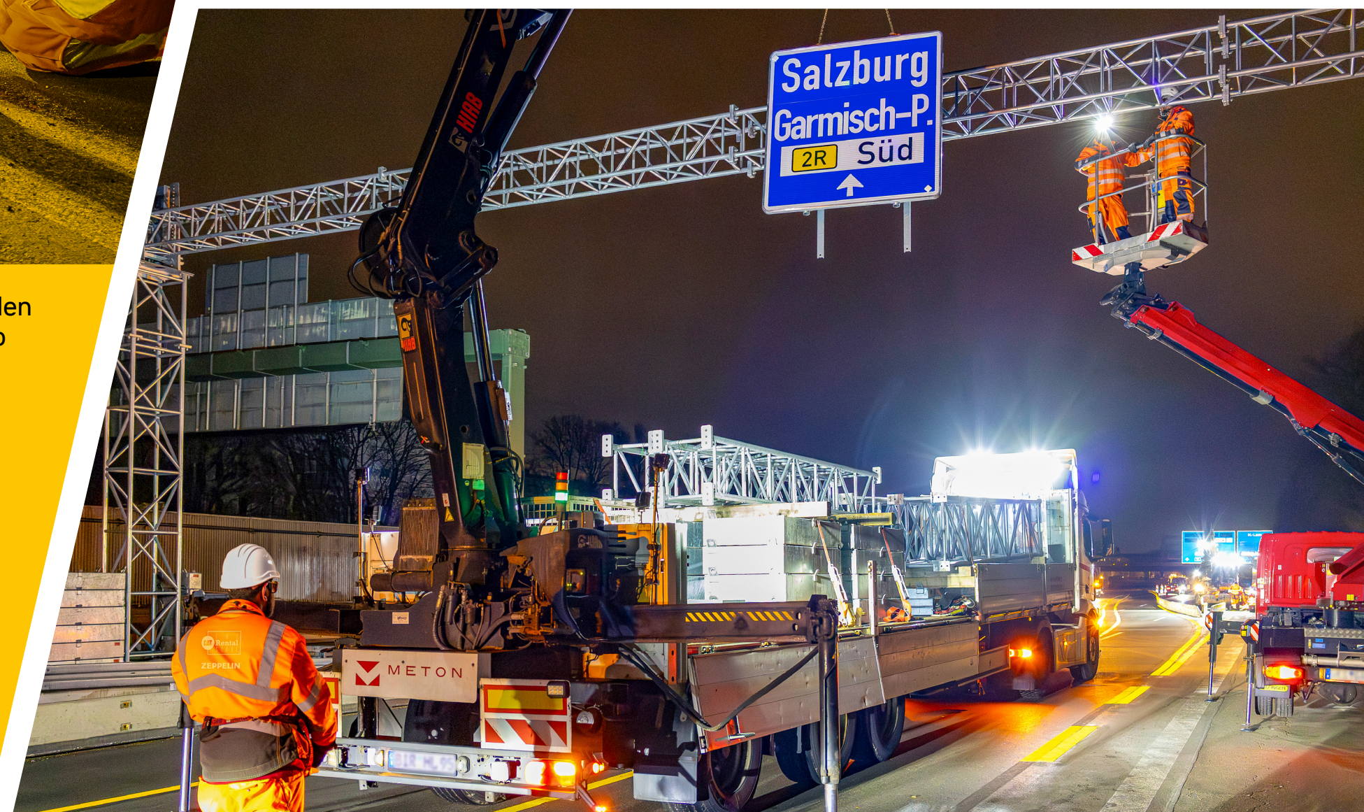
METON – eine Tochtergesellschaft von Zeppelin Rental – fertigte und montierte zwei Schilderbrücken
