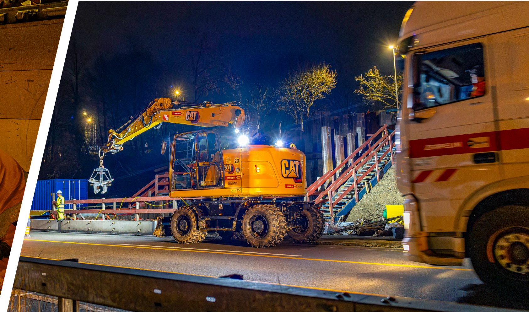
Mietmaschinen unterstützen die umfangreichen Arbeiten vor Ort
