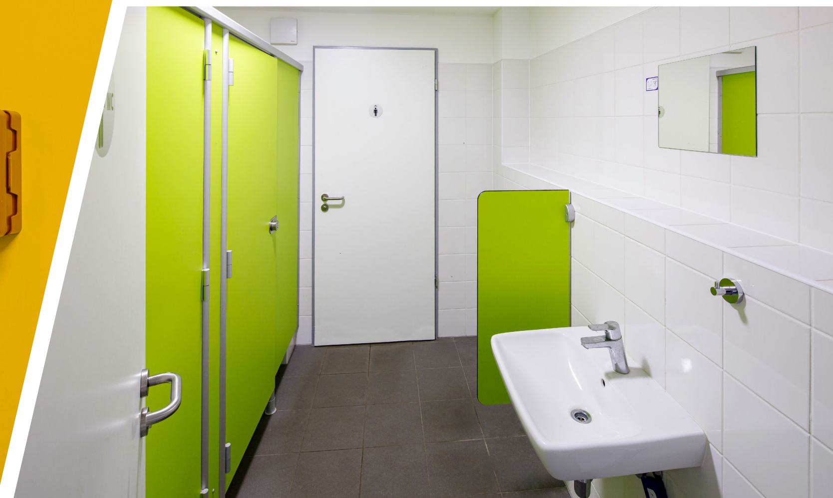
Die Sanitärbereiche wurden mit langlebigen Fliesen ausgestattet
