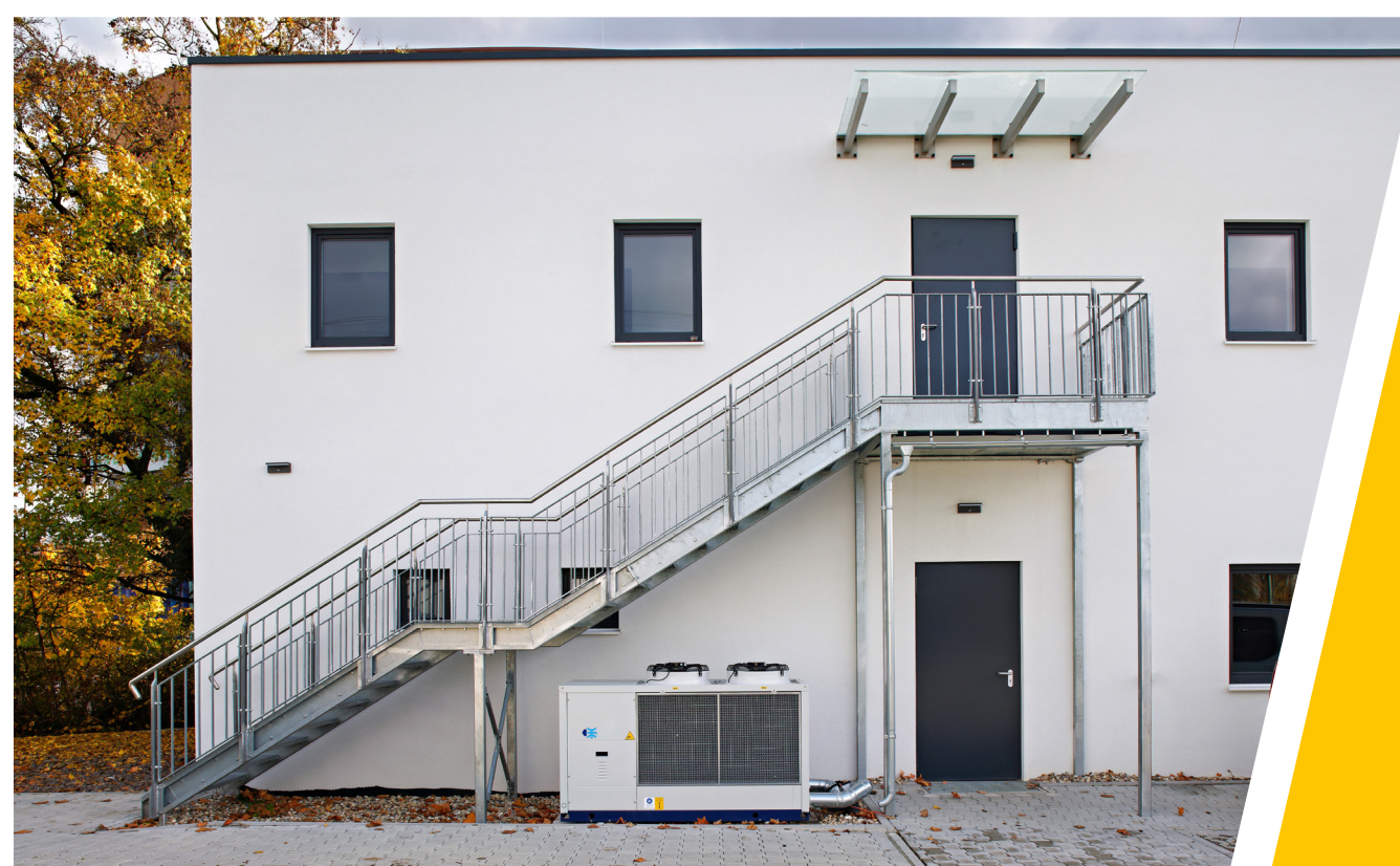
Die Außentreppe ist mit einem ein Meter hohen Geländer ausgestattet und verfügt über Podeste in Blechkonstruktion
