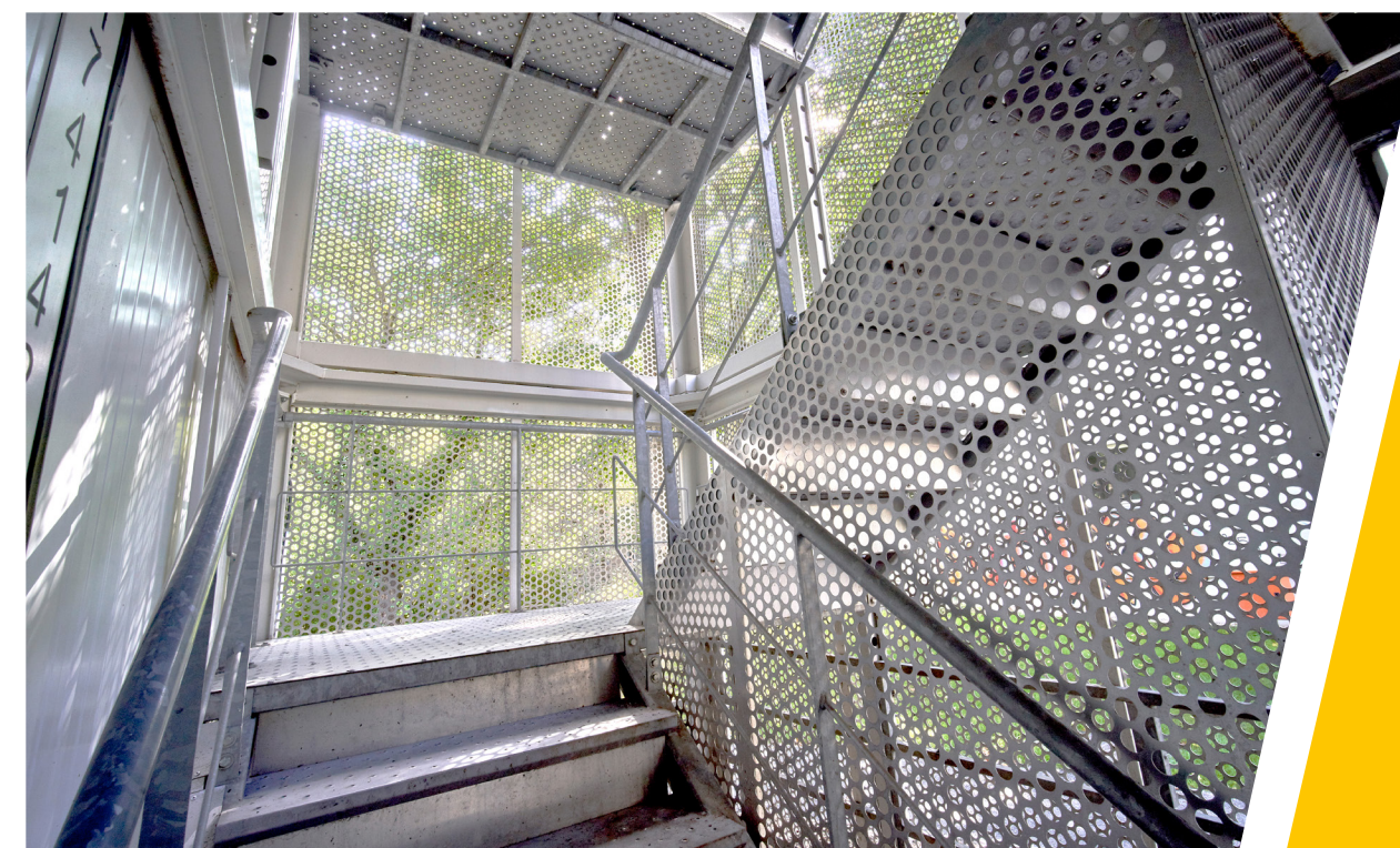
Zwei bauliche Rettungswege sind in der Baugenehmigung festgelegt – einer davon führt über das außenliegende Treppenhaus
