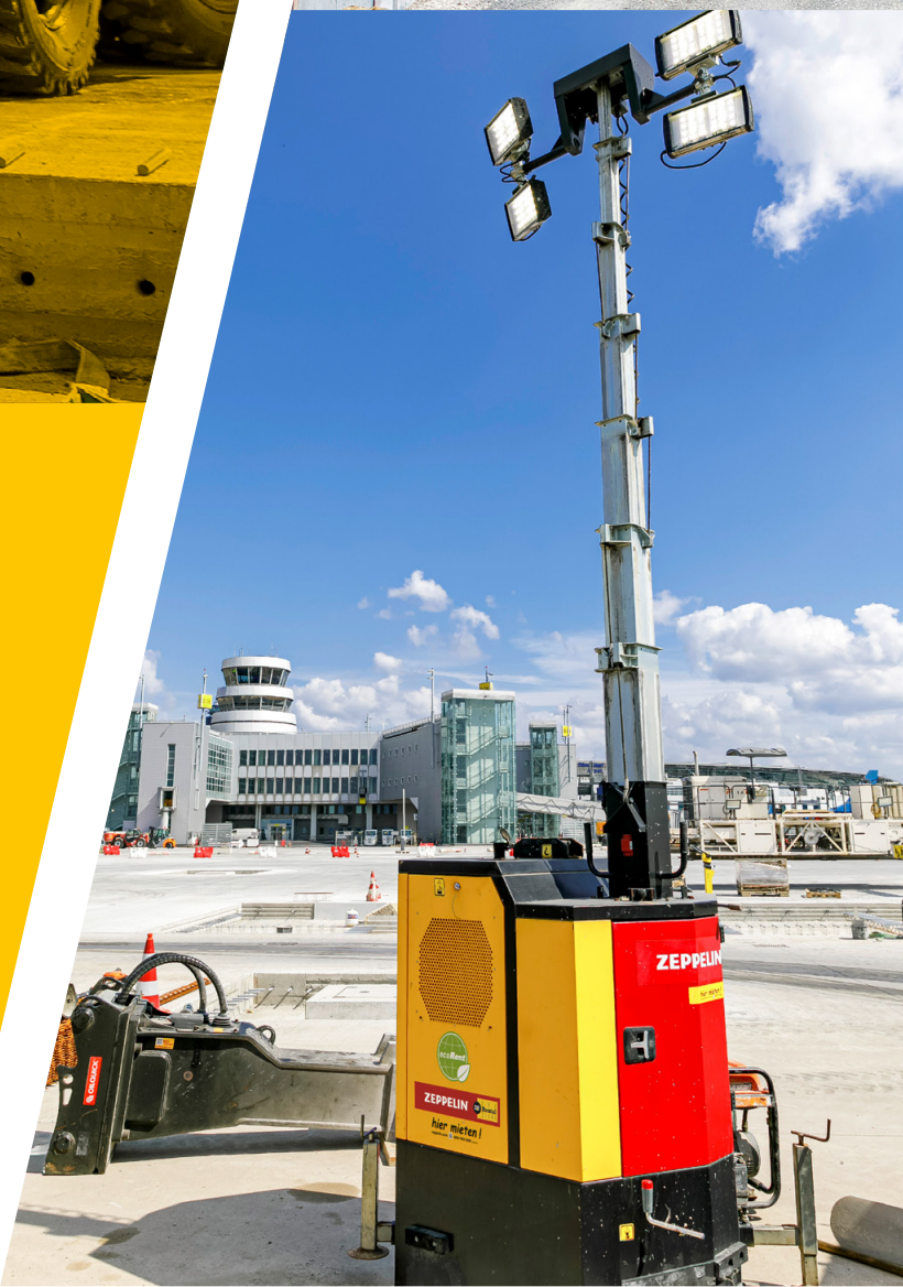
Zwei LED-Flutlichtmasten sorgten für Helligkeit während Nachtarbeiten
