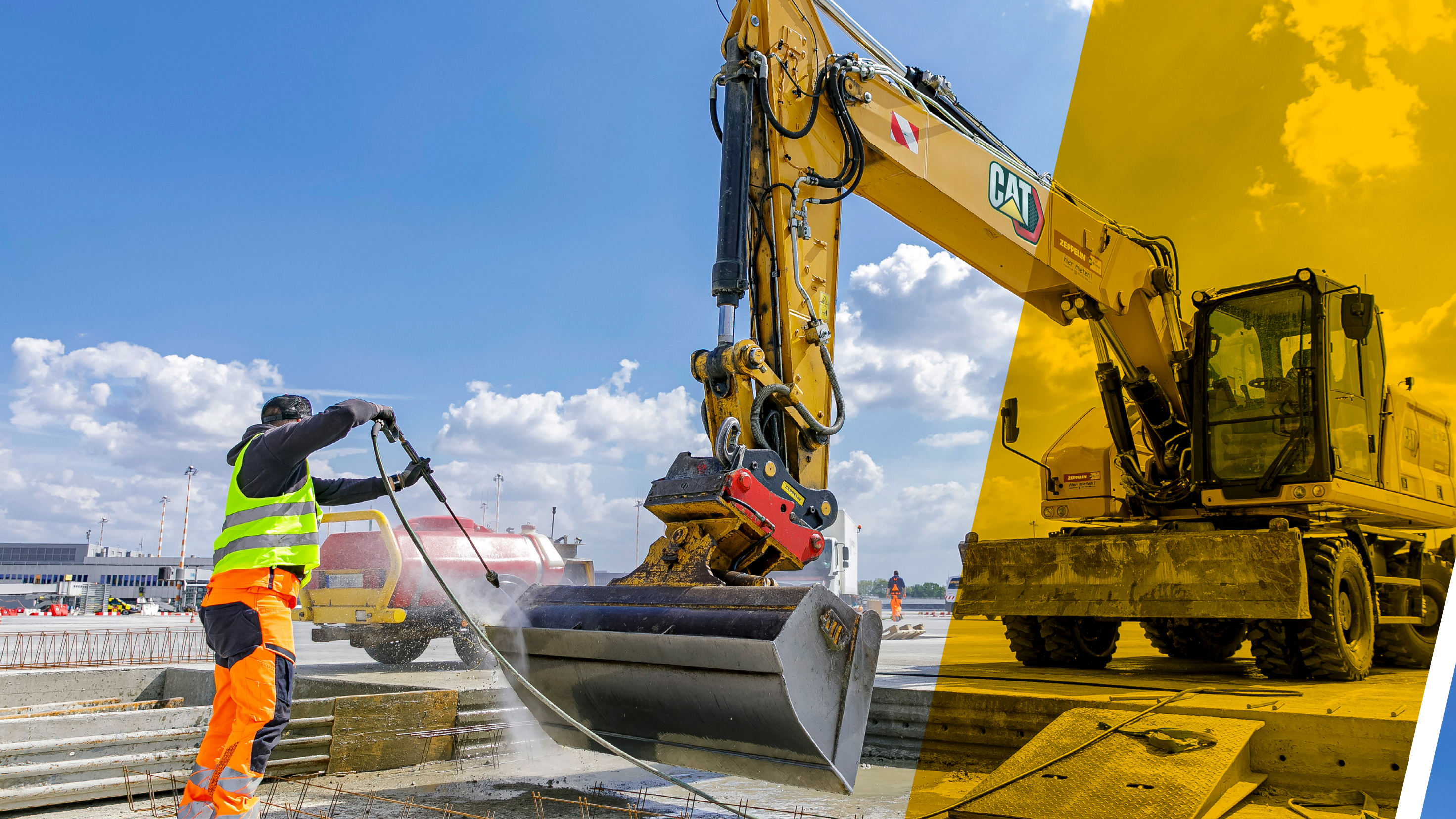
Mobile Hochdruckreiniger dienen zur Entfernung von frischem Beton an den Anbauteilen
