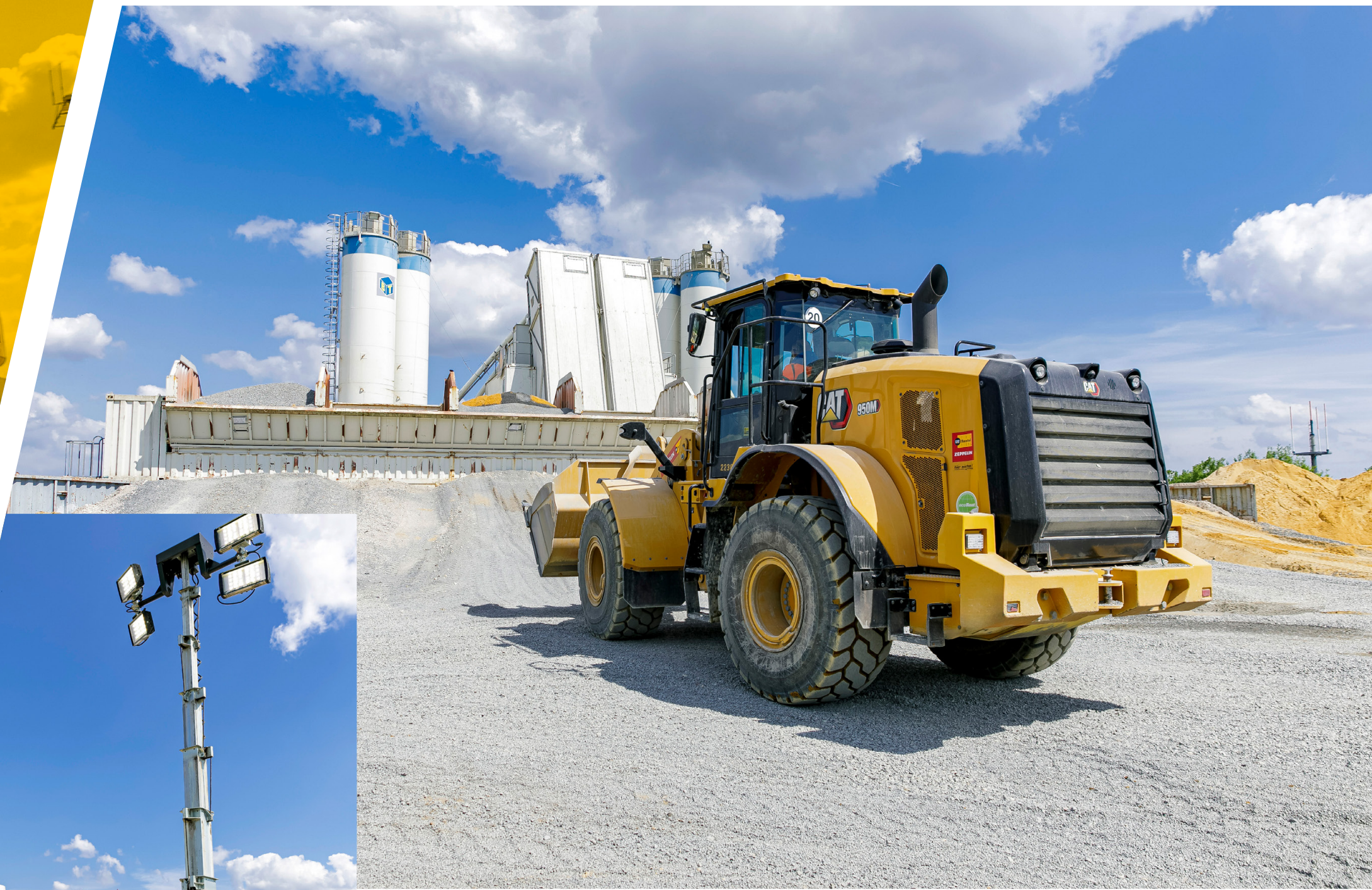
Der Radlader CAT 950 M verfuhr Material zur mobilen Mischanlage, um den Beton direkt vor Ort herzustellen
