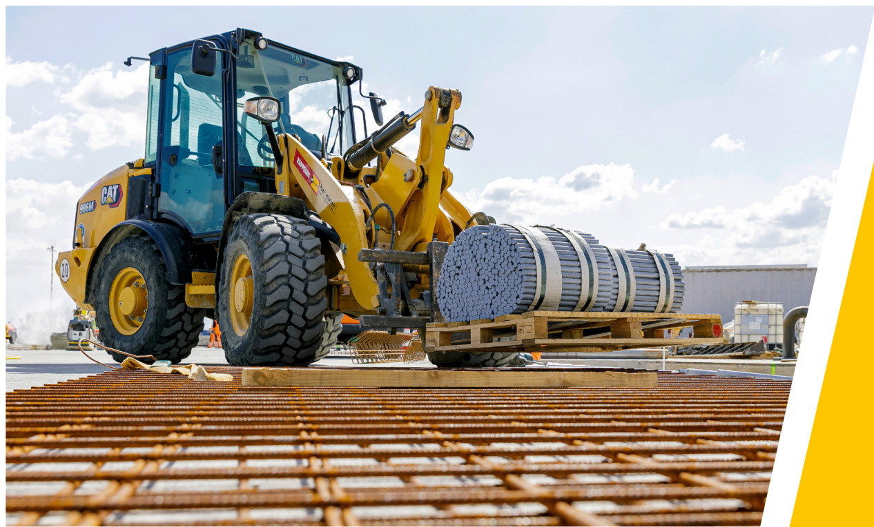
Ein weiterer Radlader vom Typ CAT 906 M übernahm den innerbetrieblichen Materialtransport
