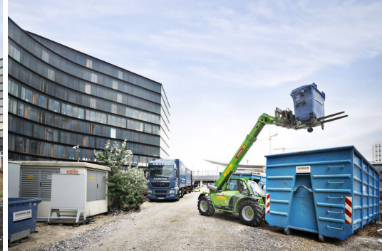
Das Entsorgungsmodell sicherte die sortenreine Trennung des Abfalls sowie die verursachergerechte Abrechnung.
