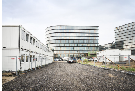
Das Containerbetreibermodell bot allen Mitarbeitern auf dem Bauvorhaben Arbeitsraum.
