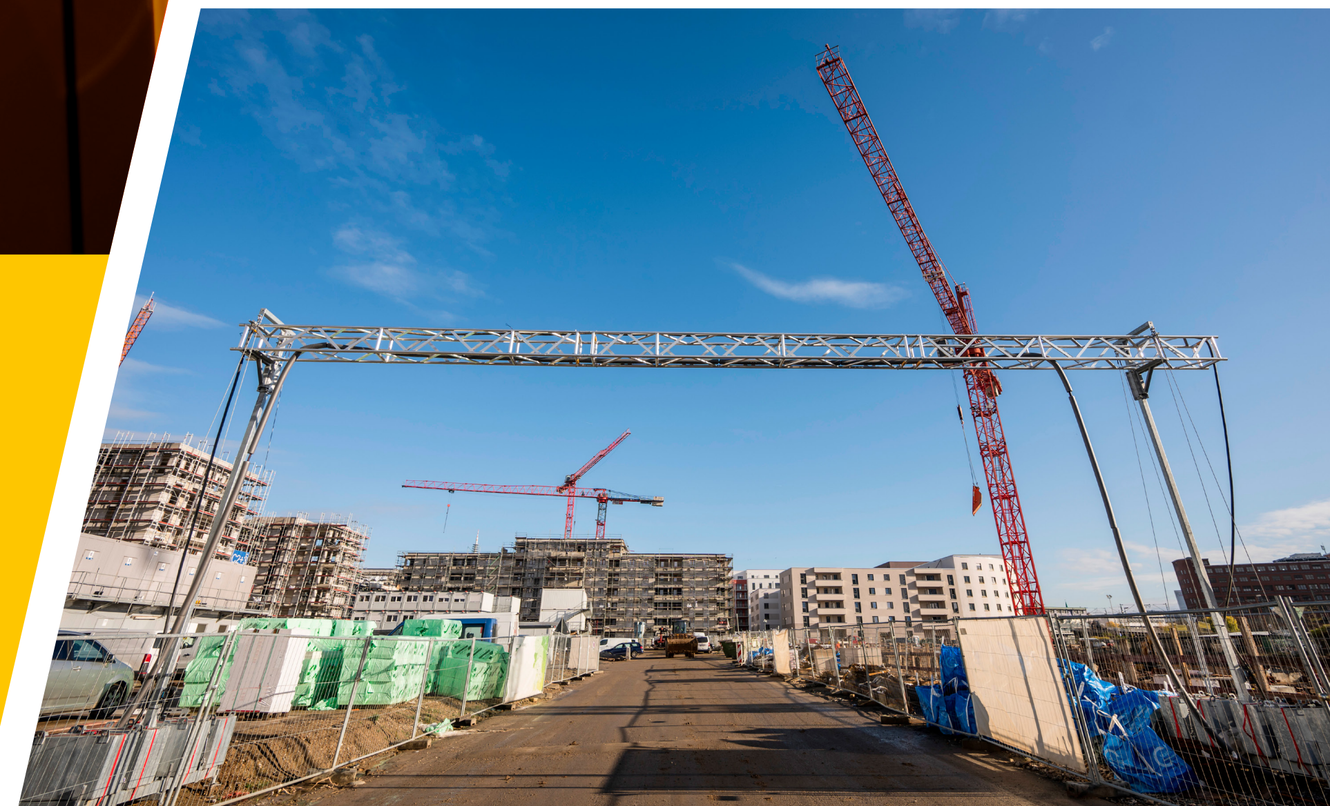
Drei Kabelbrücken zwischen elf und 15 Metern leiten das Kabel über die Baustraße
