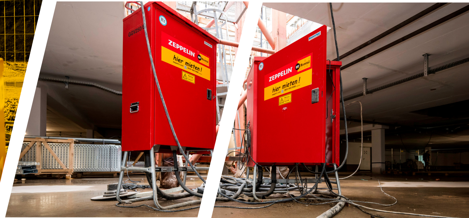
200 Stromverteiler und über acht Kilometer Kabel wurden montiert
